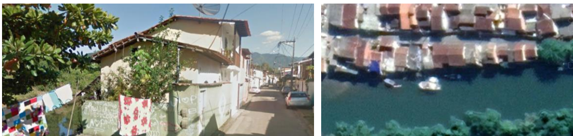
Figura 53: edificações sobre as margens do rio Matheus Nunes
